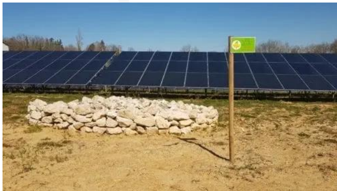
Pierriers – Centrale au sol de Boulogne-sur-Gesse
