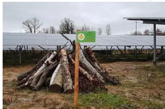
Tas de bois – Centrale au sol de Boulogne-sur-Gesse
