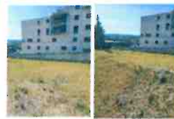
Figure 1 : logements collectifs à proximité immédiate de l'EVP.
