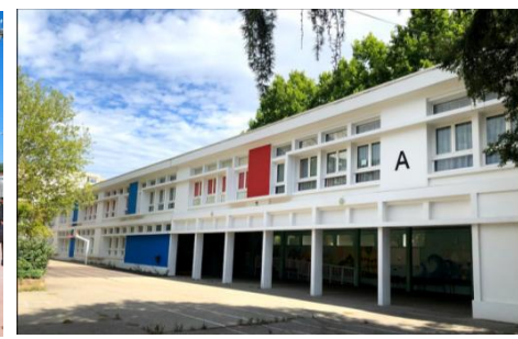
Rénovation des façades de l'école Jules-Ferry
