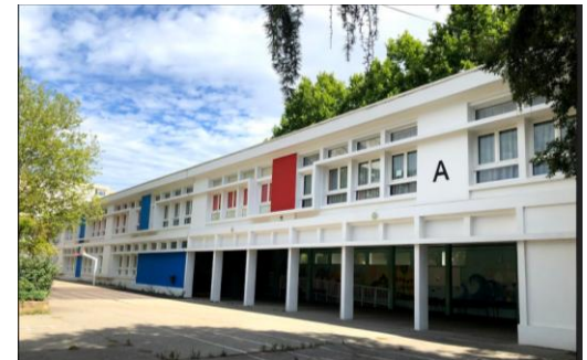
Requalification des façades de l'école Jules-Ferry
