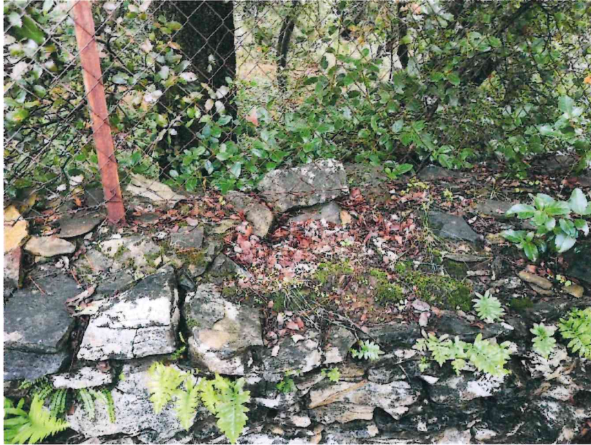
Mur en pierre
