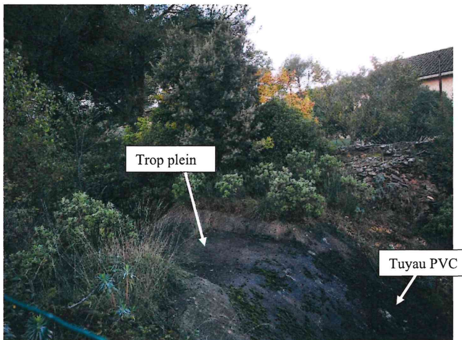
Surverse en béton
